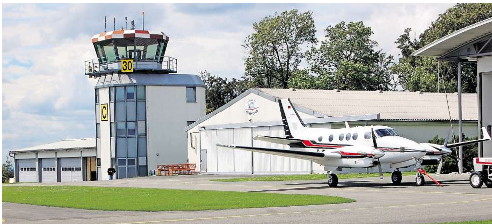
Adieu Brandensteinebene: Sollte auch der Kreistag für das Planfeststellungsverfahren stimmen, dann entsteht in Neida ein neuer Flugplatz. Die Brandensteinebene würde daraus folgend 2019 außer Betrieb gehen. Das Flugfeld und die Gebäude sollen dann beseitigt werden. Man denkt sogar an die Wiederaufforstung des Bergrückens. Archivbild
